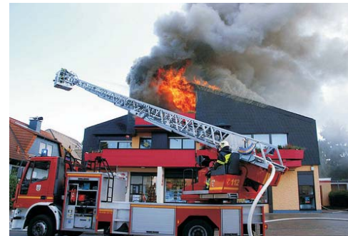
Foto: Der Dachstuhl einer Apotheke in der Bahnhofstraße im Vollbrand.
